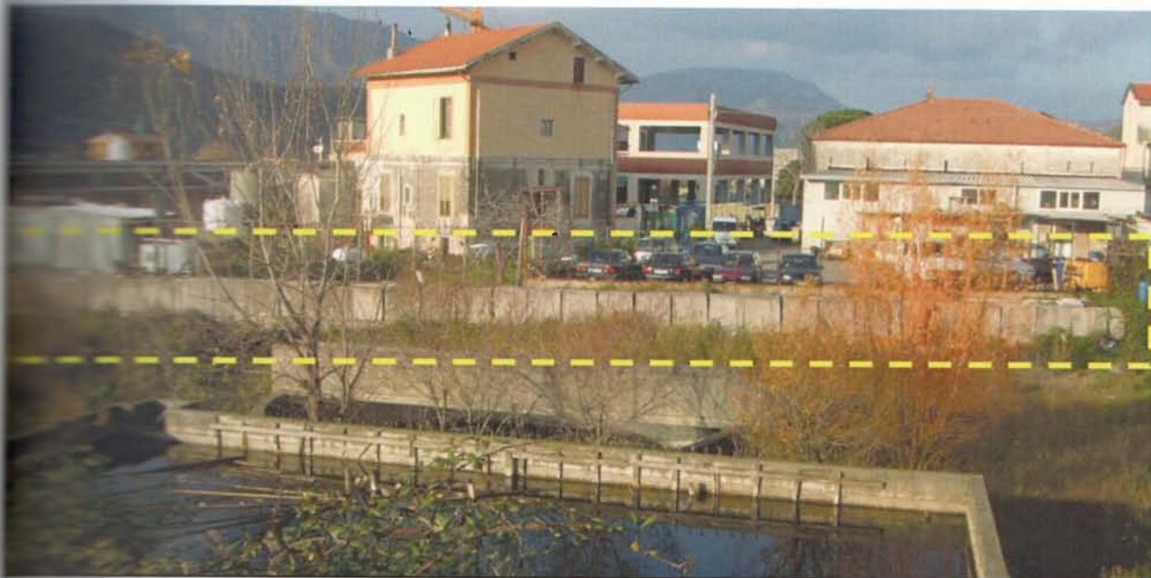
Foto 3 - Muro di contenimento
