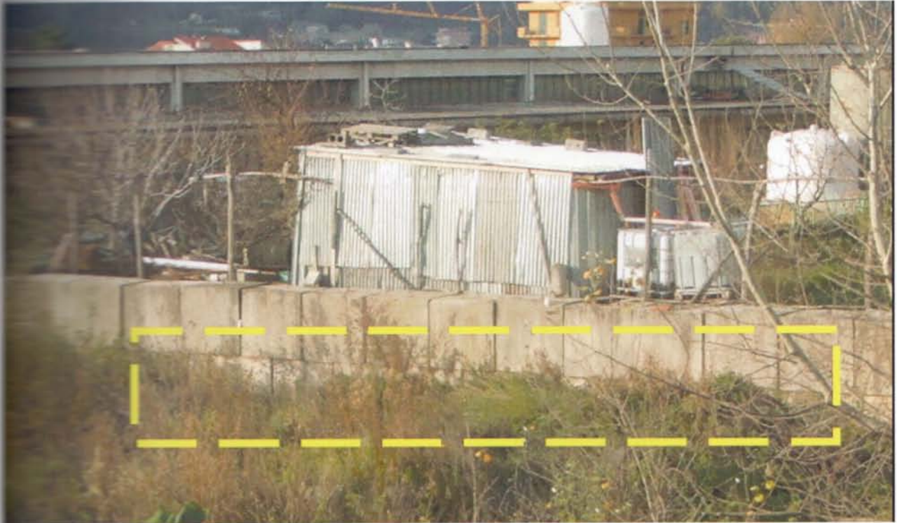
Foto 5 - Particolare ingrandito del muro di contenimento
