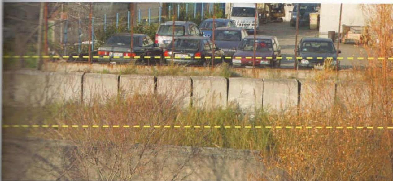
Foto 4 - Particolare del muro di contenimento
