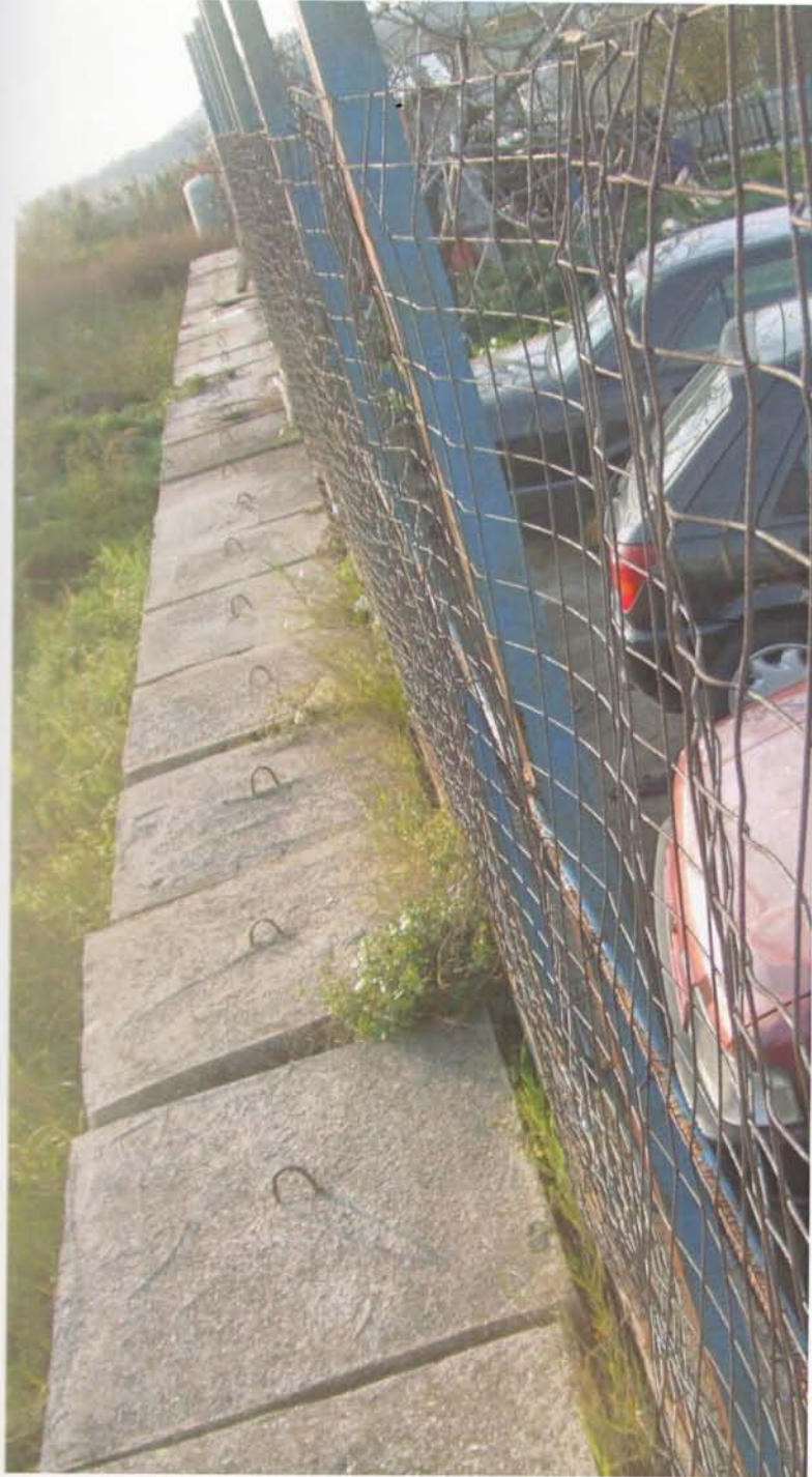
Foto 6 - Dettagli dall'alto del muro di contenimento
